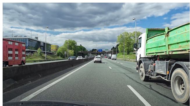
Stadumfahrung Bordeaux auf 3-spuriger Autobahn
