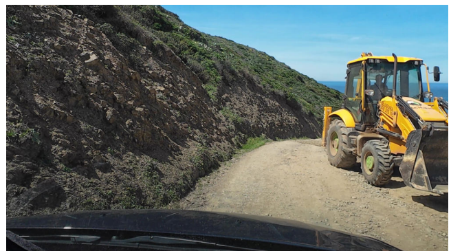
Der Baggerfahrer ist extra zur Seite gefahren, damit ich durchkomme. Viel Platz war nicht. Weiter unten war die Hälfte der Fahrbahn den Abhang hinabgerutscht. Bei Regen sollte man lieber oben bleiben.
