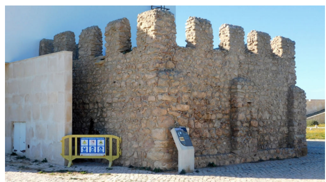
Verschlossen war auch der Zugang zur Zisterne.
