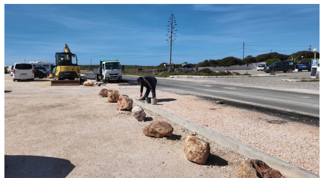
Auch hier oberhalb vom Praia do Beliche wird fleißig am Naturschutzweg mit Regenrinne gebaut. Vielleicht soll er noch bis zur Saison in 2024 fertig werden.
