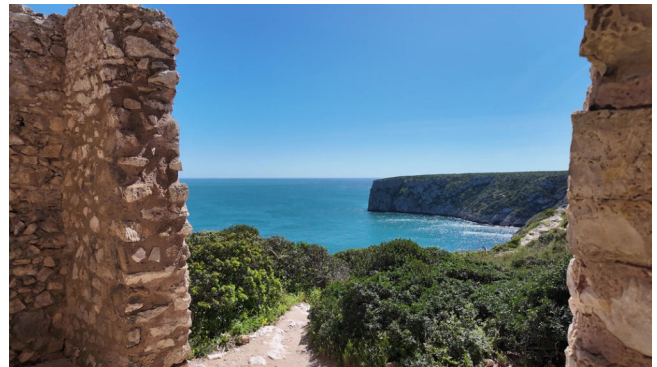
Das ehemalige Südtor der Beliche-Festung, Zugang für die anlandenden Seefahrer.
