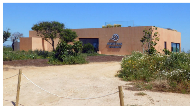
Das Restaurant MONTE MAR war 2018 gut besucht, jetzt aber geschlossen und ringsum eingezäunt.
