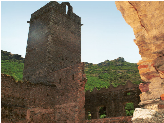
Einer der beiden großen Türme
