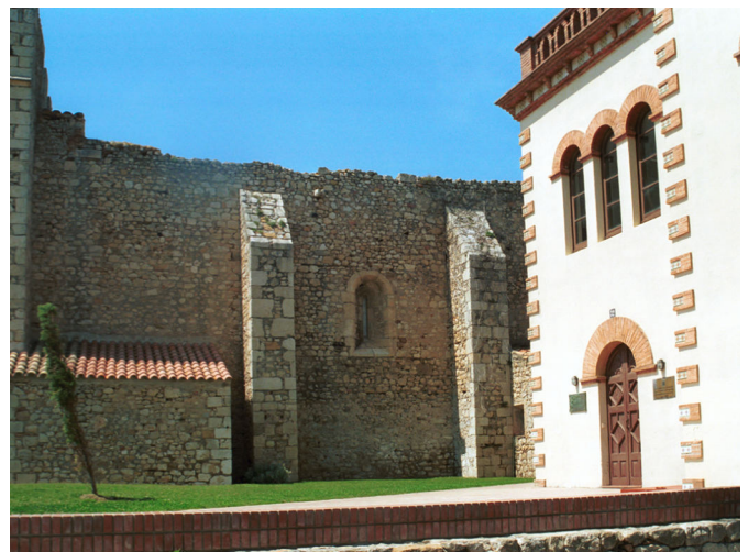
Restauriertes Gebäude und Reste der Kirchenmauer
