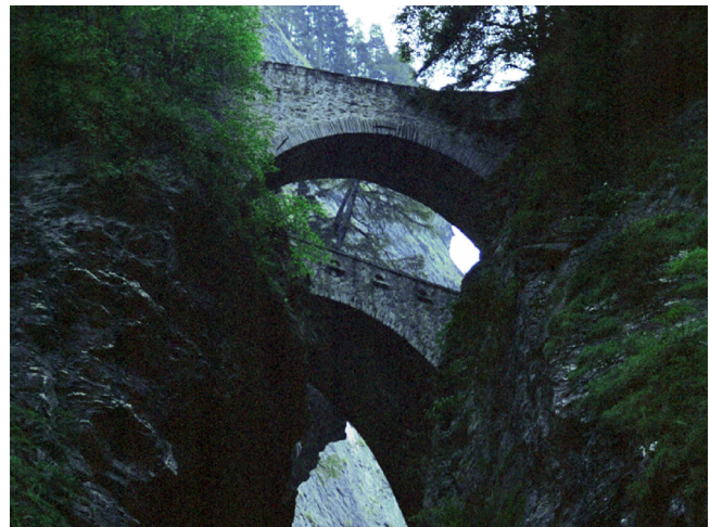
Brücken über die Viamala-Schlucht
