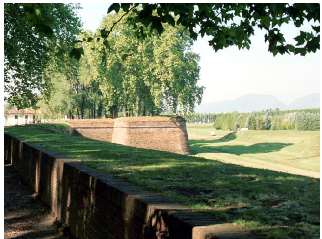
In der erhöhten Wehranlage sind viele Räumlichkeiten.
