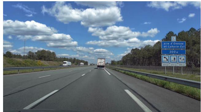
A63 Richtung Bordeaux, Parkplatz Aire de Onesse Est
